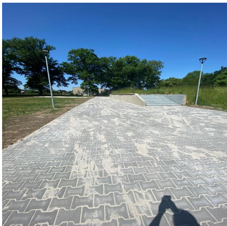
Fot. Chodnik i zagospodarowanie terenu na terenie po starym Basenie.
