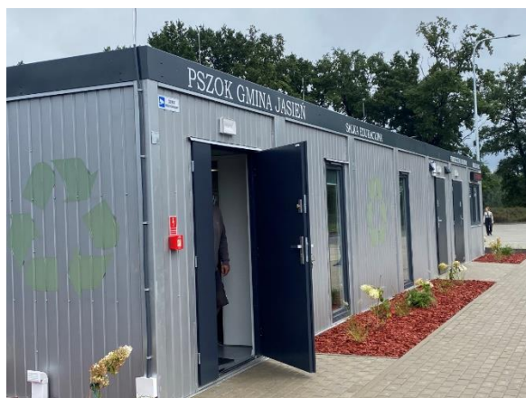
Fot. Budynek socjalno-biurowy z salką konferencyjną (zasoby własne).
