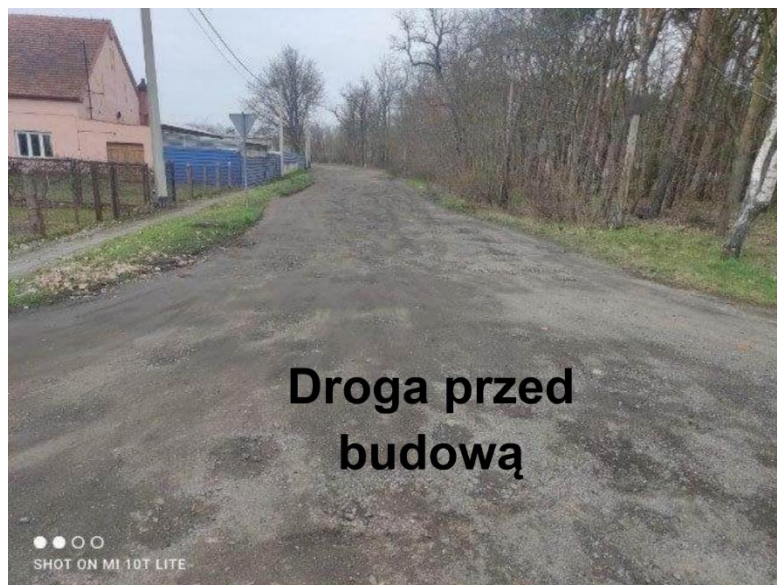
Fot. Droga przed budową (zasoby własne.)
