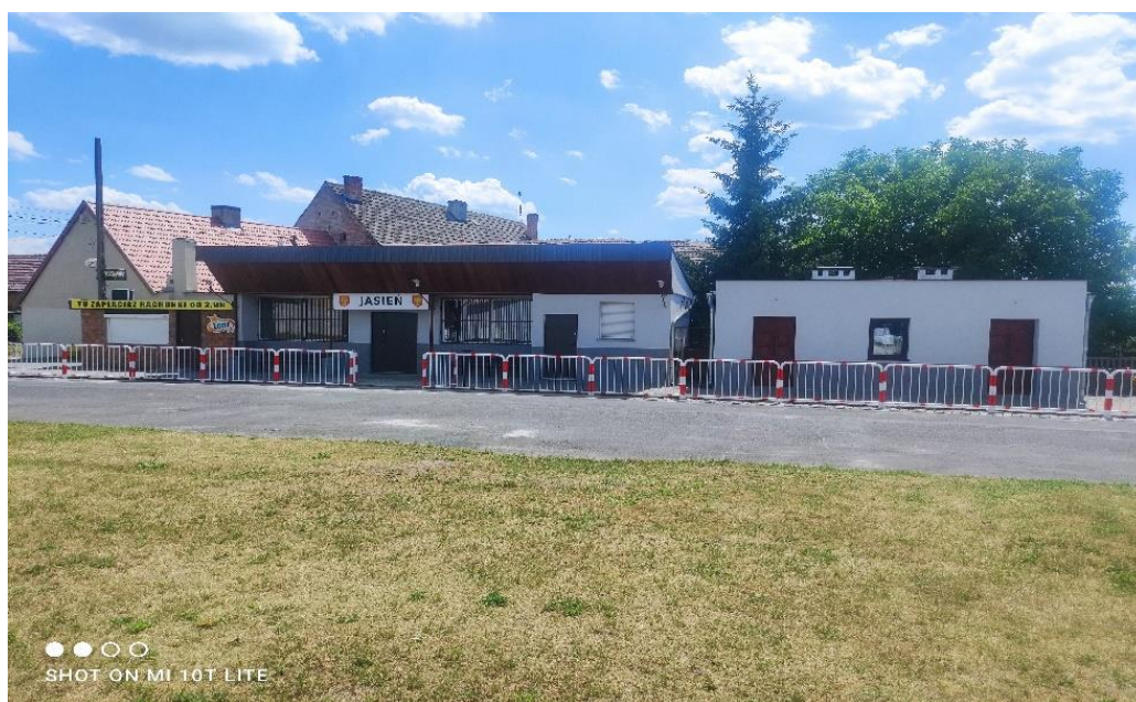
Fot. Wyremontowany budynek PKS i Szalet miejski w Jasieniu
