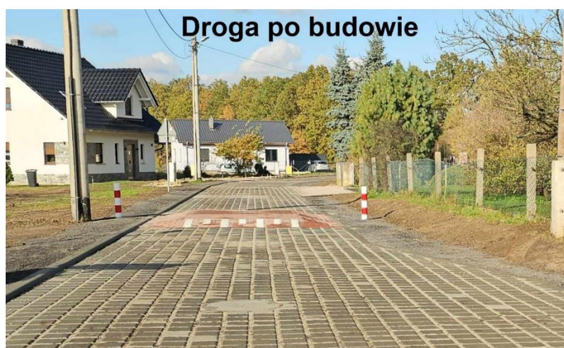
Fot. Droga po budowie (zasoby własne).
