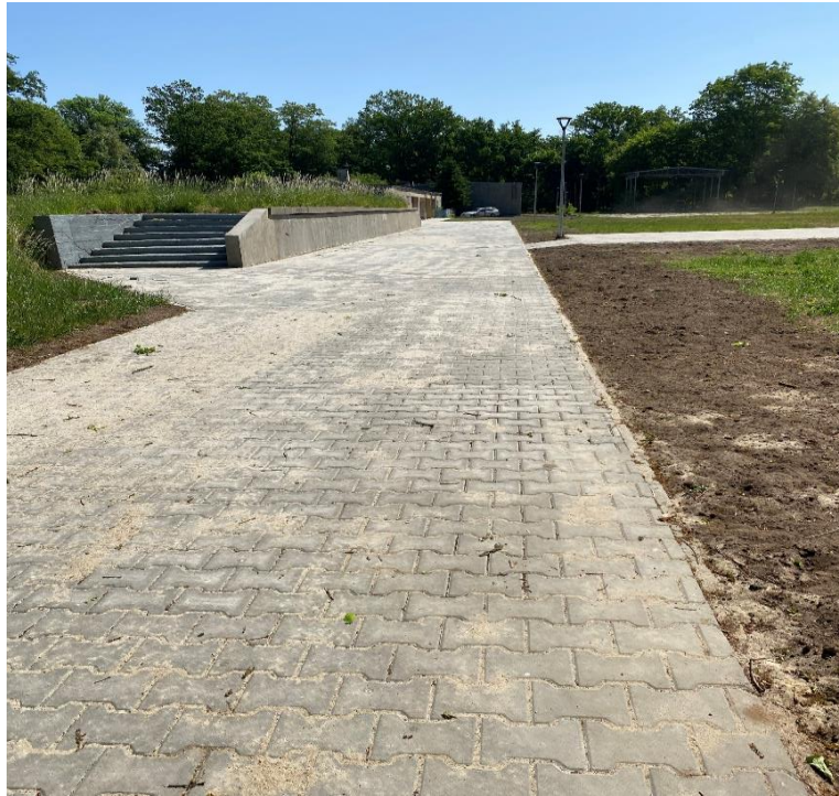
Fot. Chodnik i zagospodarowanie terenu na terenie po starym Basenie.
