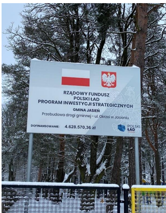
Fot. Tablica informacyjna realizacji inwestycji
